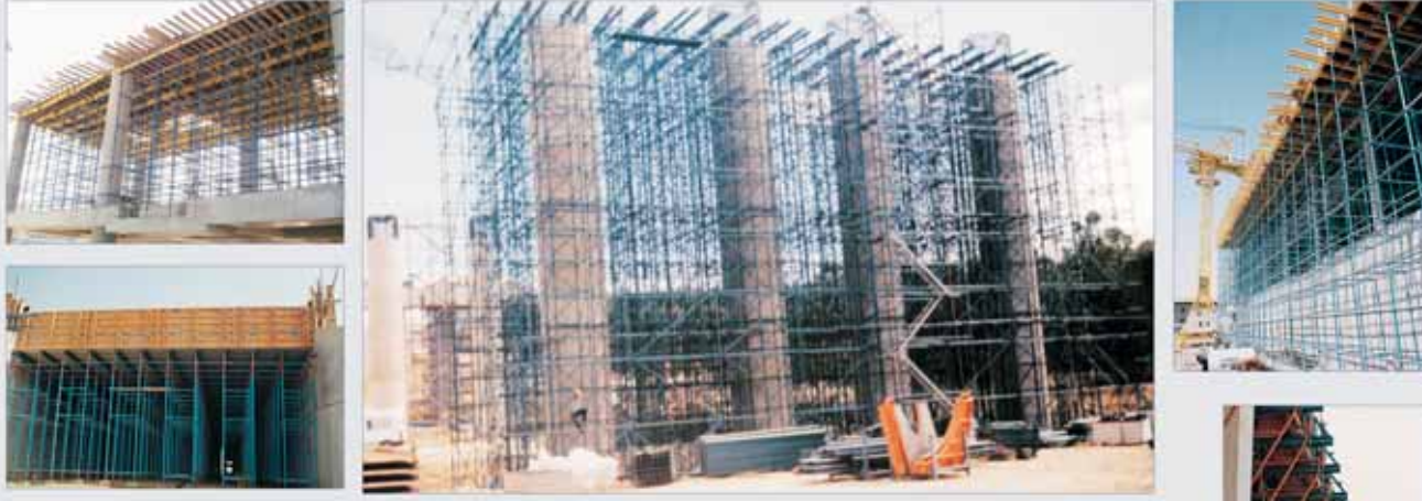
Taşıyıcı İskele Sistemi Shoring for Slab Formwork
